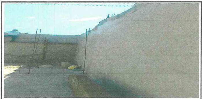
Foto 6: Levantado de hiladas de block para que quedara en el nivel apropiado.
