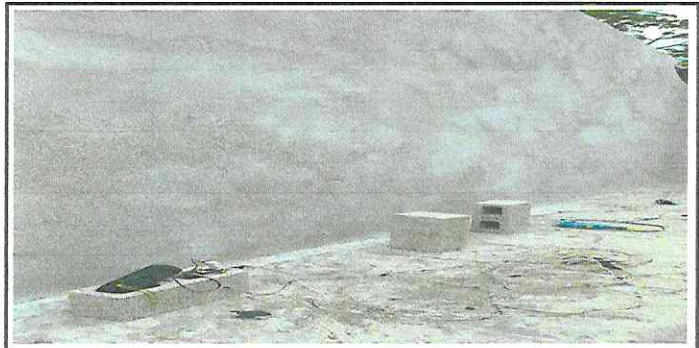
Foto 4: cernido de las paredes que ya estaban construidas.
